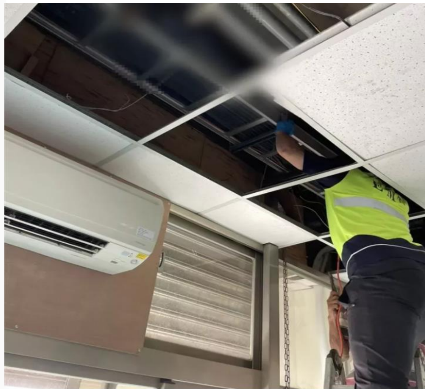
新竹某科技公司維修鐵捲門，竟因未斷電，導致維修工程師觸電身亡。記者巫鴻瑋／翻攝
