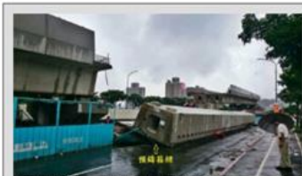
淡水捷運輕軌工程發生預鑄箱樑翻覆。（新北市政府勞檢處提供）
