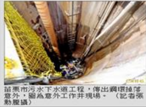
苗栗市污水下水工程，傳出鋼環掉落意外，圖為意外工作井現場。(記者張勳騰攝)
