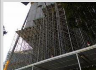
施工大樓鐵條墜落，差點打中在等公車的小朋友。(圖源自爆料公社)
