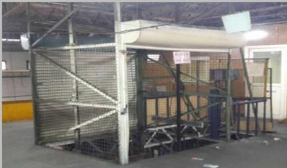
大甲幼獅工業區內工廠，十九日發生貨梯下墜，造成一死一重傷慘劇，肇事原因，刻由警方調查處理中。記者陳榮昌 / 攝
