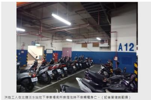
洪姓工人在此捷運淡水站地下停車場廁所換燈泡時不幸觸電身亡。(記者曾健銘拍攝)
