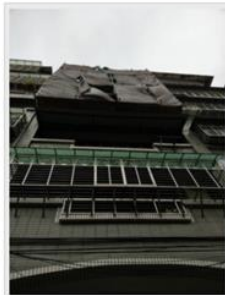
劉姓工人在公寓維修外牆時，疑似不慎失足從4樓摔下，重摔在1樓路面。(記者曾健銘攝影)
