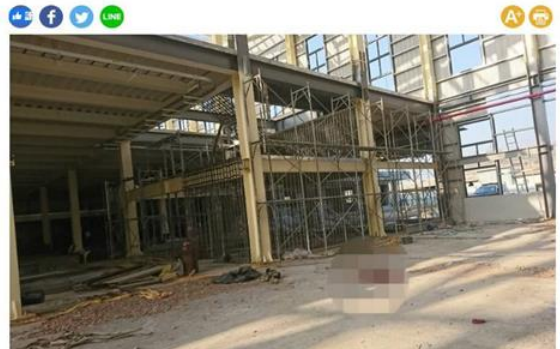
台中一名林姓工人，今天下午搭設烤漆板屋頂，不慎摔落地面命危，現場地面還留有血跡。(記者黃連志翻攝)
