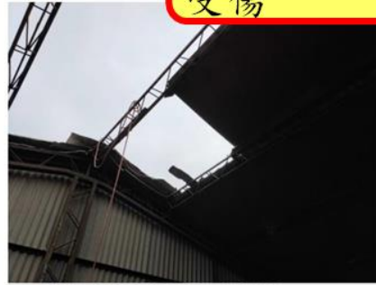
工人在拆屋頂鐵皮屋的石棉瓦時墜落到3樓頂。(記者楊金城翻攝)
