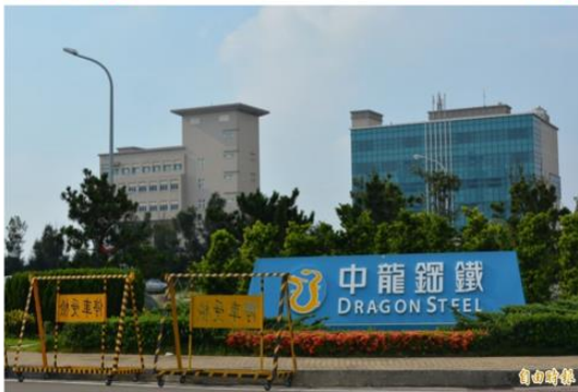
中龍鋼鐵一名員工今天上午進行維修作業時，遭長80公分、直徑5公分的鑽製軸心射進下腹部並從腹部穿出，幸未傷到內臟、骨髓、大動脈。(記者陳建志攝)
