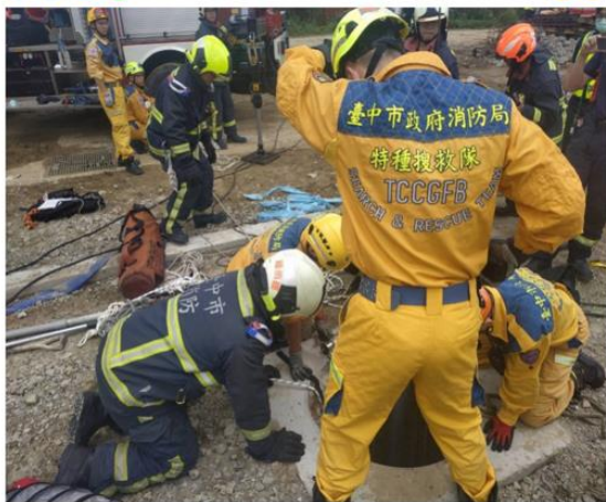
消防人員進入10米深涵管援救。(圖由消防局提供)
