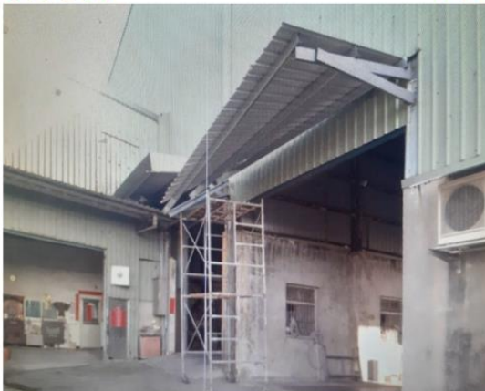
新竹縣新豐鄉1家碾米廠今天下午傳出2名工人約6公尺高的鷹架墜落的意外，造成1死1傷，意外發生原因由警方蒐證調查中。(記者廖豐茹翻攝)
