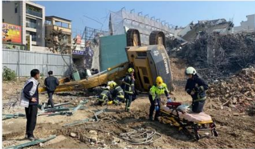
台中市北屯區一處工地，昨天進行拆除作業時，由蔡姓男子駕駛的怪手，從二樓翻覆至一樓，蔡被壓住胸部，送醫不治。記者陳宏睿 / 攝
