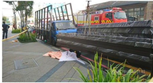
台中市消防局25日上午獲報在北屯區崇德十路一段前，一名工人在進行採光罩施工搬運時，不慎撞擊物壓住，消防人員到場發現工人已明顯死亡，現場交由警方與勞檢單位處理。（翻攝照片）中央社記者蘇木春傳真 110年2月25日
