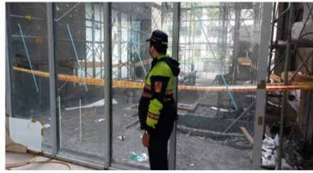
工地現場拉起封鎖線，新莊警分局提供
