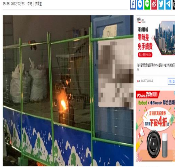
高雄左營區一處工地22日一個乙炔鋼瓶突然起火燃燒。(翻攝照片/高雄分項處攝)
