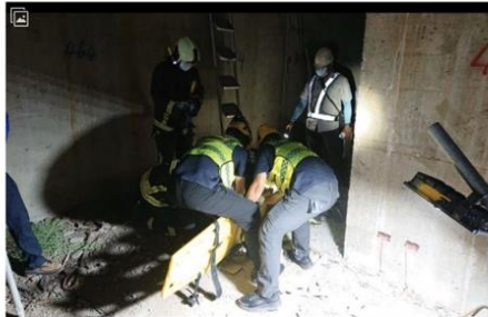
▲大立光電第三廠房新建工程傳出工安意外，一名工人從高處墜落，遭鋼筋刺穿腹部，消防人員抵達時已無生命跡象，緊急送醫搶救仍宣告不治。(圖/通訊畫面)
