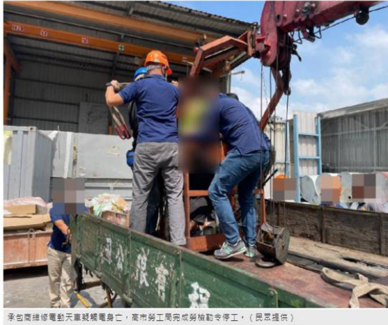
承包商維修電動天車觸電身亡，高市勞工局完成勞動勒令停工。(民眾提供)
