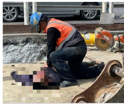
▲工人切割管壁時，被管內負壓吸入慘死。(圖/民眾提供)
