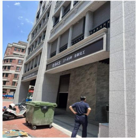
北市大同區今發生工安事件，陳姓工人疑更換照明燈遭電擊送醫搶救。記者蕭雅娟／翻攝
